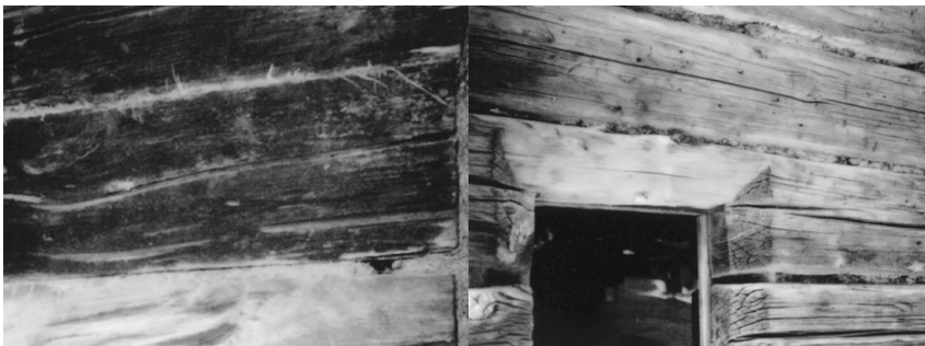
Bild 1.1: Bei Holzblockbauten diente mitunter Moos und Lehm als Dichtmaterial für Fugen und Ritzen. (Foto: Eicke-Hennig)
