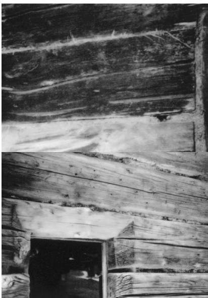
Bild 2.1: Bei Holzblockbauten diente mitunter Moos und Lehm als Dichtmaterial für Fugen und Ritzen. [Foto: Eicke-Hennig]
