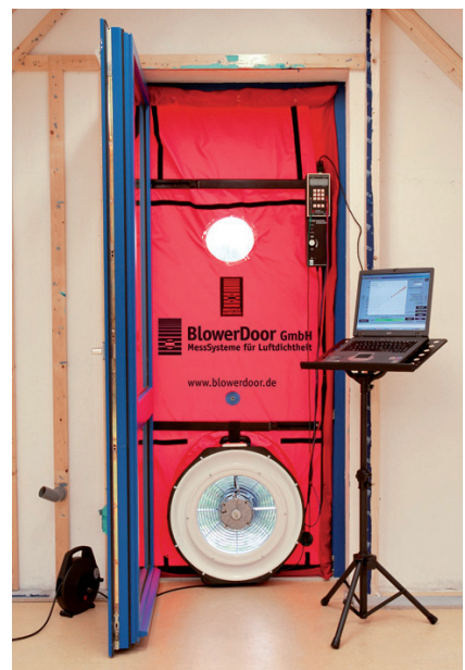
Bild 3.2: Foto einer eingebauten Blower-Door. [Foto: BlowerDoor GmbH]
